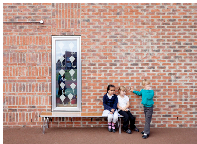
Slika 4: Oblikovanje fasade z opeko, ki je bila uporabljena že na stari šoli, ki so jo porušili. Sandal Magna Primary School, Anglija, arh. Sarah Wigglesworth Architects, (Sarah Wigglesworth Architects, b.d.). Foto: Mark Hadden.
