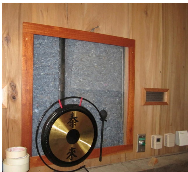
Slika 6: Prozorna obloga omogoča prikaz naravne toplotne izolacije iz recikliranega bombaža. The Willow School, ZDA, arh. Farewell Architects LLC, (Hiltner, 2013). Foto: Steve Hiltner
