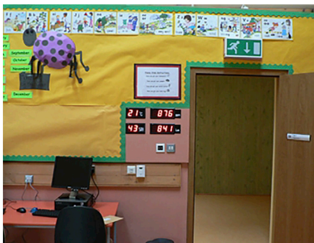
Slika 7: Prikaz temperature zraka in količine CO 2 v učilnici. Osnovna šola Acharacle Primary School, Škotska, arh. Gaia Architects (Hartman, 2009).
