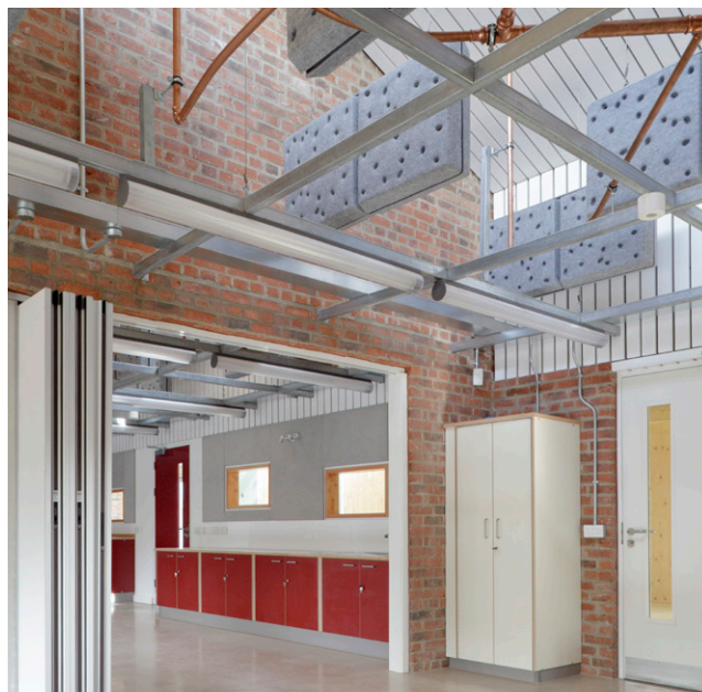
Slika 8: Vidne instalacije in akustične plošče so v vlogi dekorativnih elementov, hkrati poučujejo o komponentah, potrebnih za obratovanje stavbe. Sandal Magna Primary School, Anglija, arh. Sarah Wigglesworth Architects (Sarah Wigglesworth Architects, b.d.). Foto: Mark Hadden
